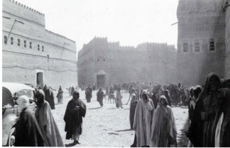
الشكل (3-8): صورة توضح ارتفاع فتحات الشبابيك عن المارة لحجب الرؤية
