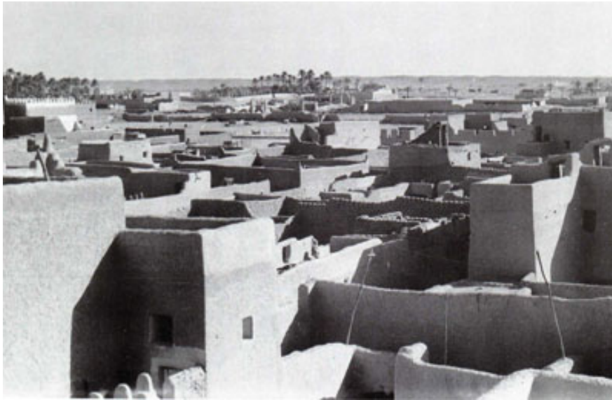
الشكل (3-7): صورة توضح تماثل الارتفاعات وعدم إطلال المباني كل منها على الآخر
