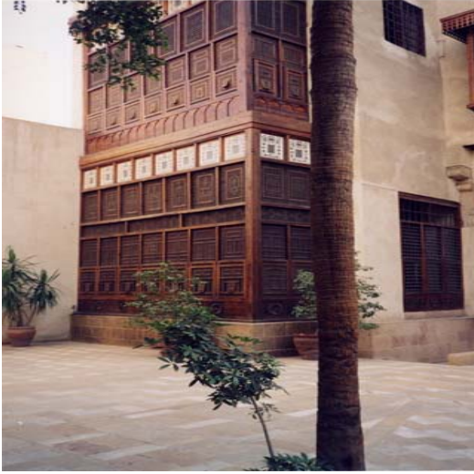
الشكل (3-10): فكرة المشربيات والتي تحجب الرؤية الخارجية بشكل فني
