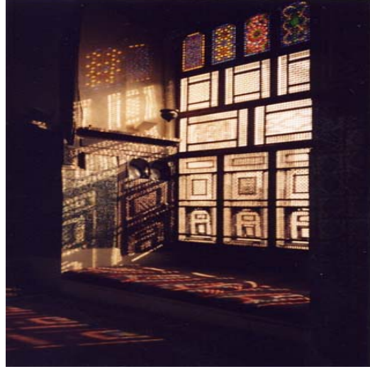
الشكل (3-10): فكرة المشربيات والتي تحجب الرؤية الخارجية بشكل فني
